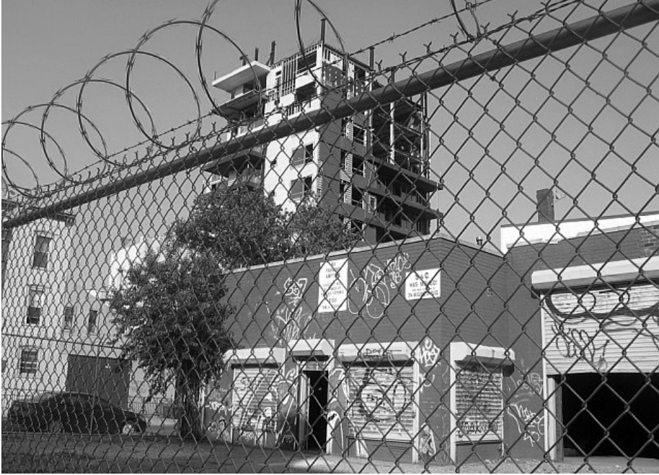
Figura 4 Veduta da "sevenberry", che sovrasta la stazione di servizio.
